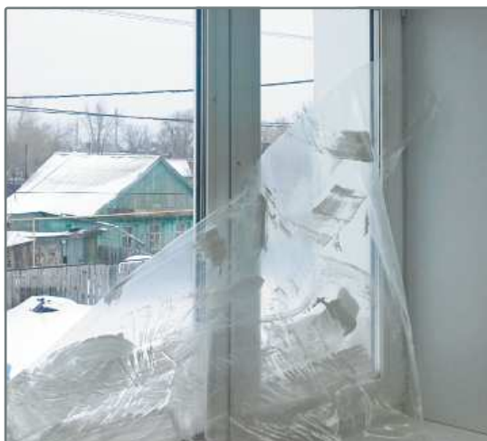
ВРЕМЕННАЯ ЗАЩИТА ОКНА ПРИ ШМР (ШТУКАТУРНО-МАЛЯРНЫХ РАБОТАХ)
